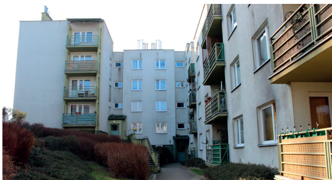
Budynek przed remontem
